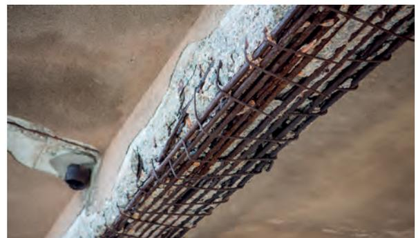
La corrosione delle armature metalliche ha espulso il copriferro. A causa dell’armatura troppo fitta il calcestruzzo non è penetrato negli interferri
