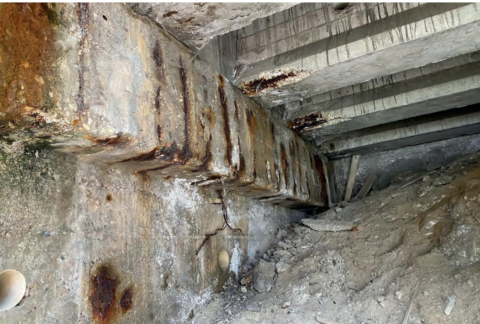
Pulvino e travi degradate per effetto della carbonatazione
