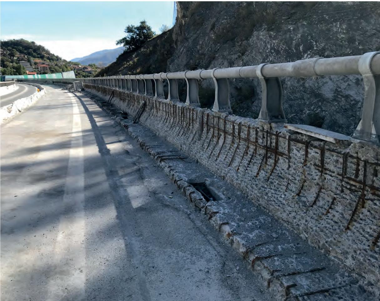
Idrodemolizione di barriere autostradali
