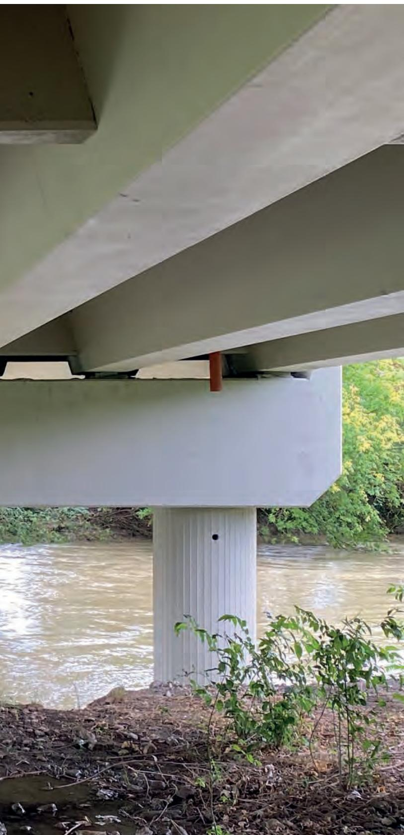
Protezione pile e pulvini mediante Rivestimento (C)
