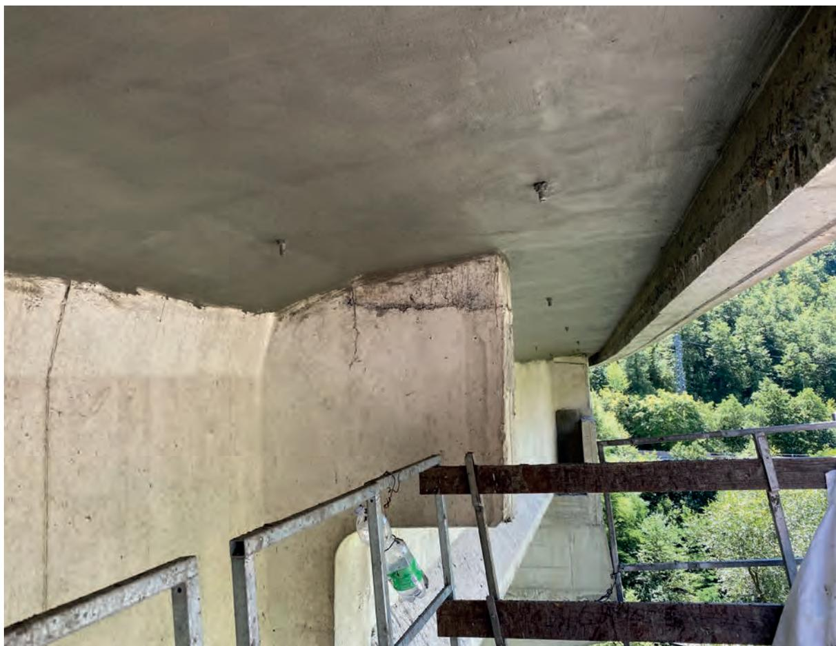
Rasatura di regolarizzazione a spessore sottile
