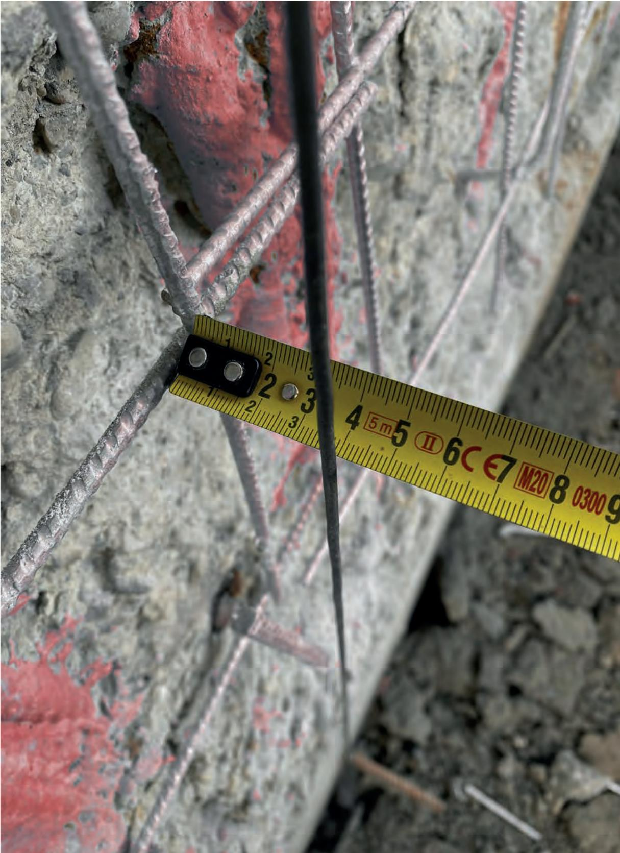
Rinforzo con rete elettrosaldata integrativa in acciaio inox
