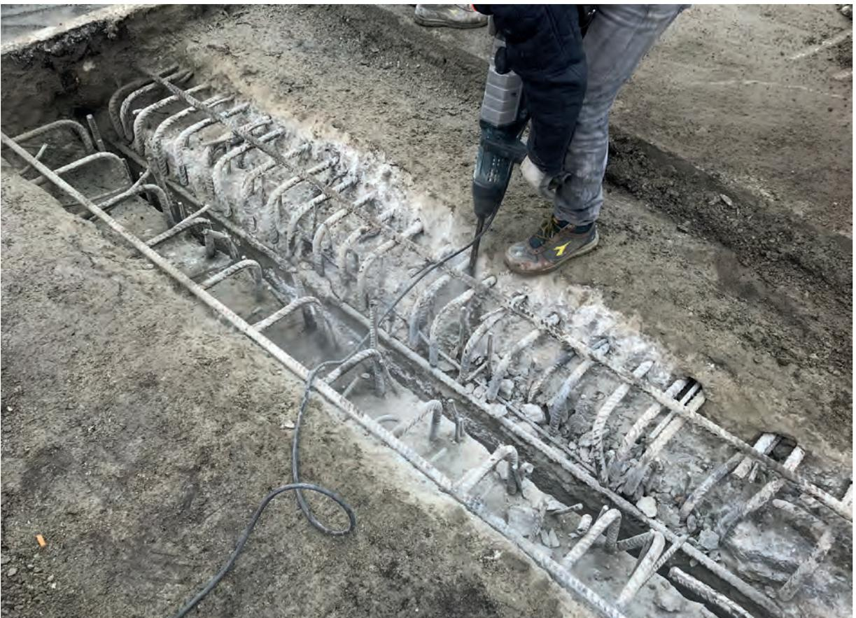
Demolizione manuale con martello pneumatico
