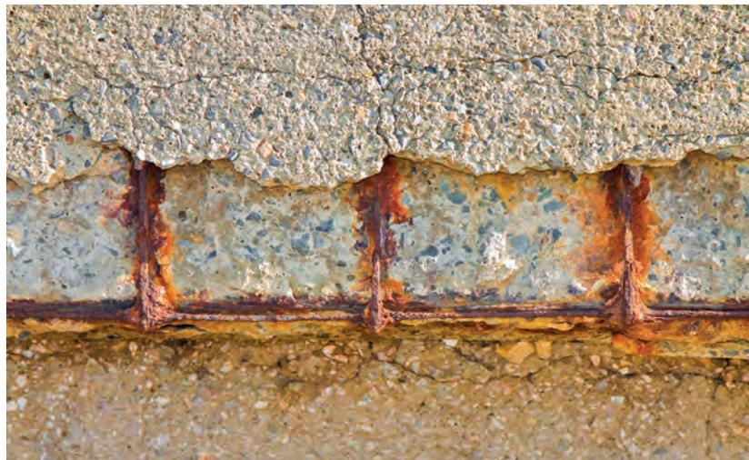
Calcestruzzo carbonatato e corrosione dell'armatura metallica
