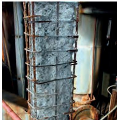
Demolizione corticale di un pilastro
