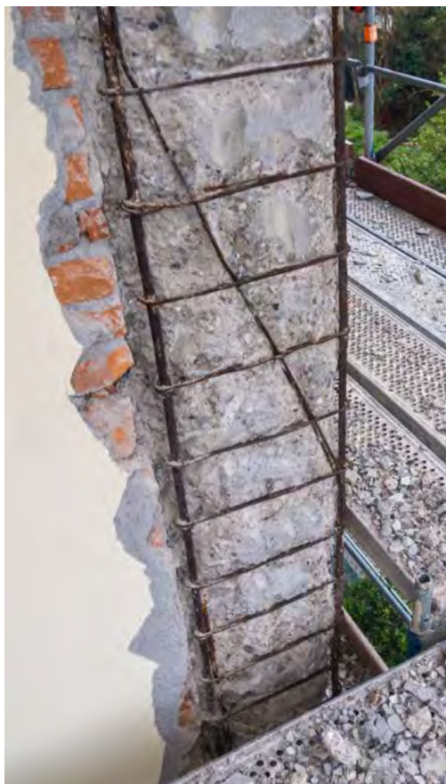
Esempi di elementi in c.a. da ripristinare.
